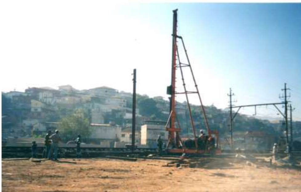
Figura 6: Construção da Passarela sobre a estrada de ferro. Fonte: arquivo pessoal.
