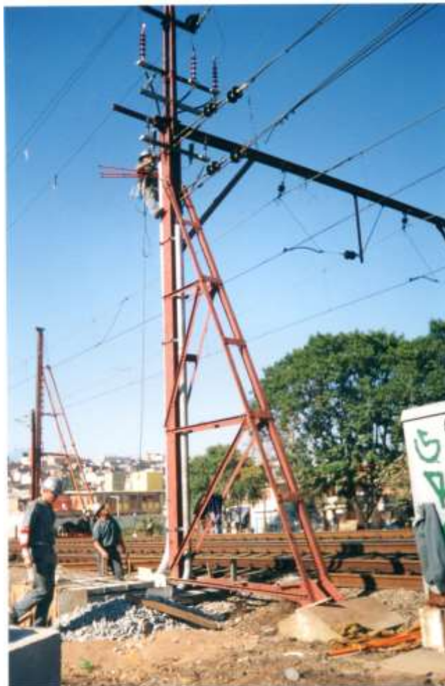
Figura 7: Construção da Passarela sobre a estrada de ferro. Fonte: arquivo pessoal.
