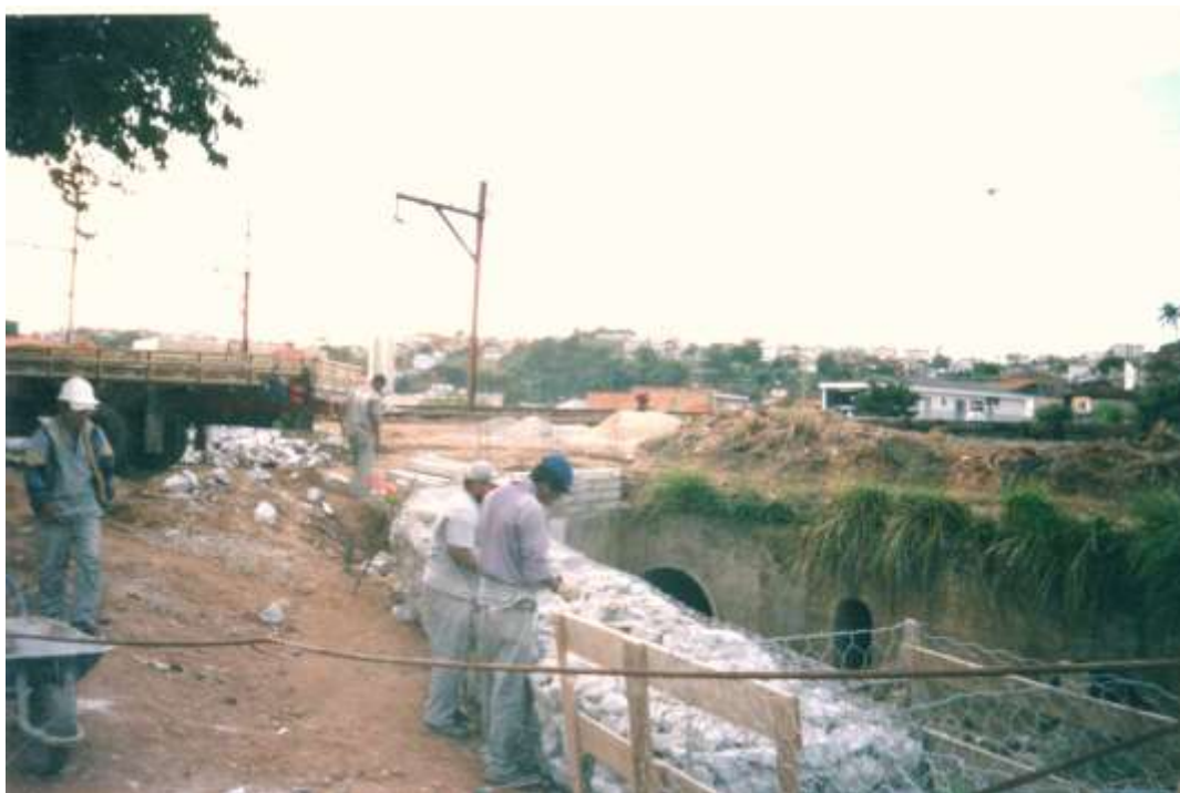
Figura 9: Construção do gabião no córrego. Fonte: arquivo pessoal.
