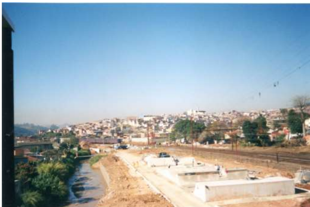
Figura 8: Construção da pista de skate. Fonte: arquivo pessoal
