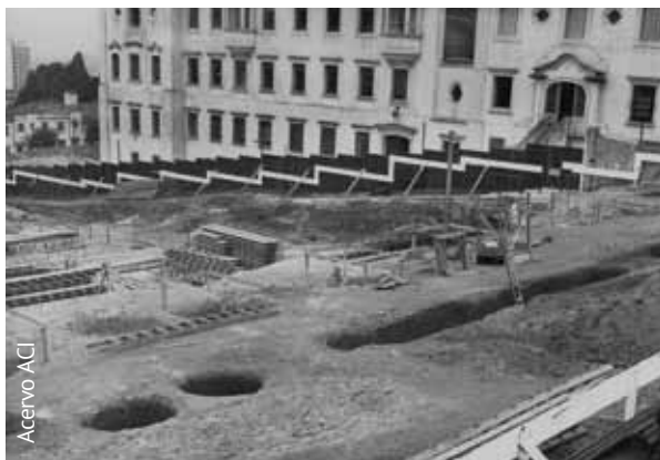
Começo dos anos 1960: em construção
