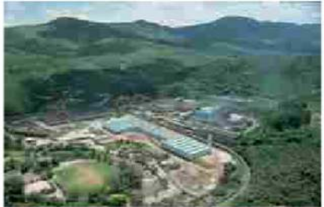
Usina de Sabara
